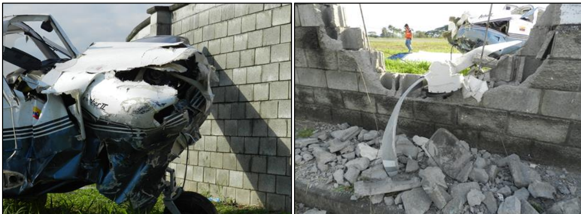
Fotografía No. 3: Impacto frontal contra el muro
